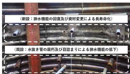
〈図〉長寿命化対策（水ボーリング工）
